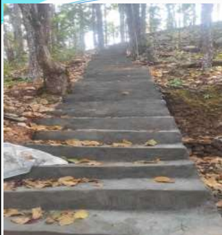
सिर्दी बाटो निर्माण
